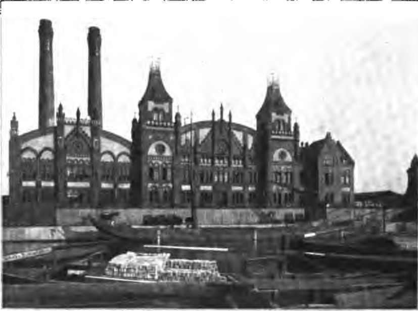
Abb. 121. Das städtische Elektrizitätswerk.
